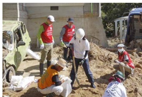
図 13. 重機で車移動後の土砂出し
