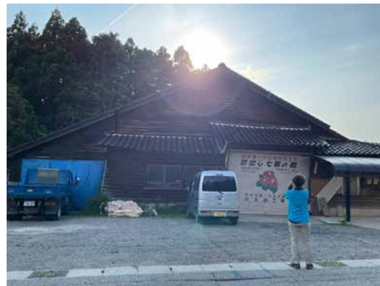
珪藻土の切り出し七輪の工場。建屋に傾きが
