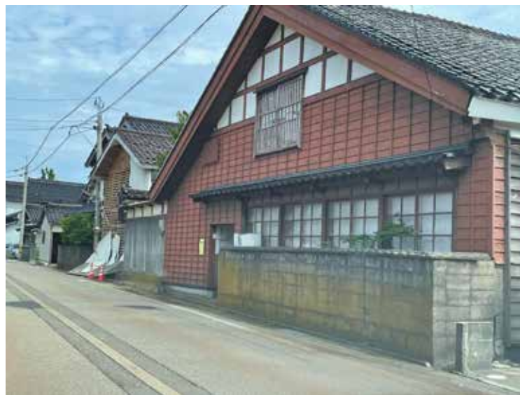
発災から1か月余り。建物の診断が進んでいる
