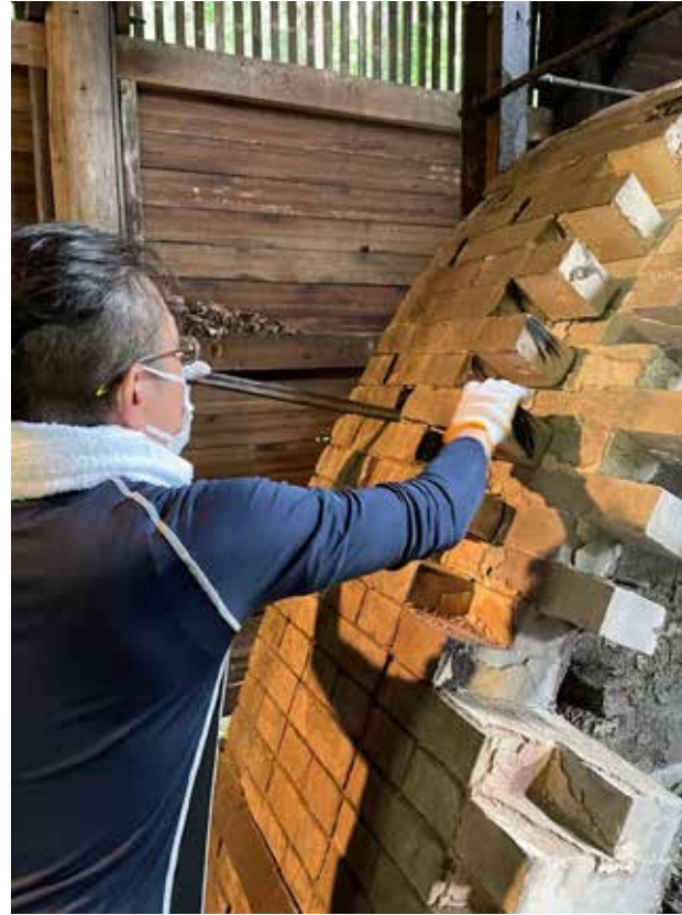
モルタルでついているレンガを1つ1つ取り外す
