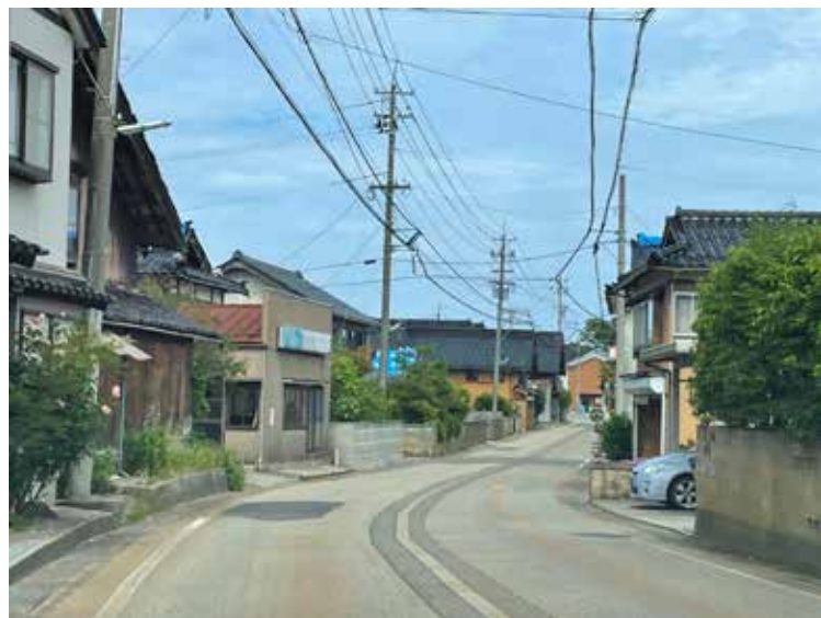
建物被害が多かった地区の街並み
