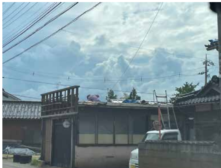
屋根の修理中
